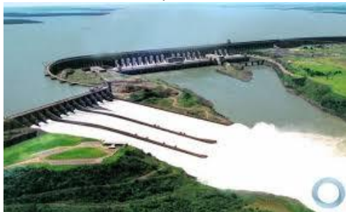
Hidrelétrica Itaipu – Brasil / Paraguai
